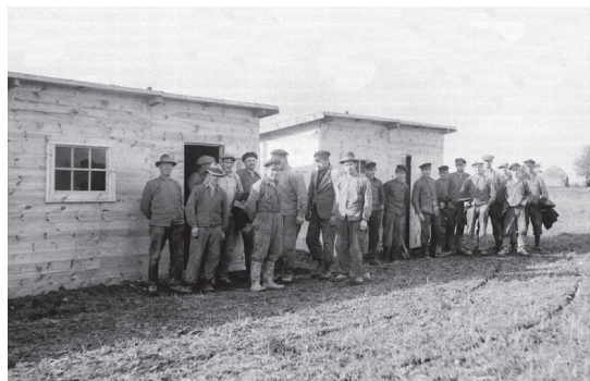
För måltider och raster hade några enkla skjul byggts upp. Foto via Eslövs Fotoklubb.
