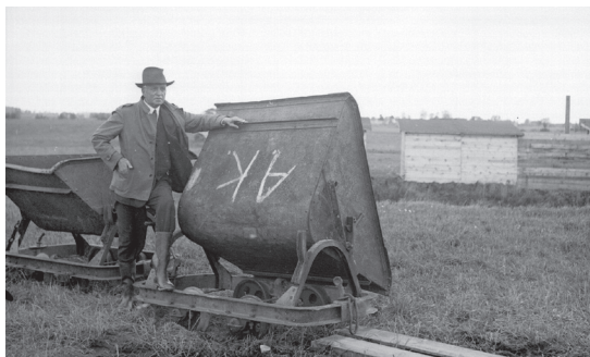
För att underlätta arbetet användes även en décauvillebana vars vagnar drogs av hästar.
