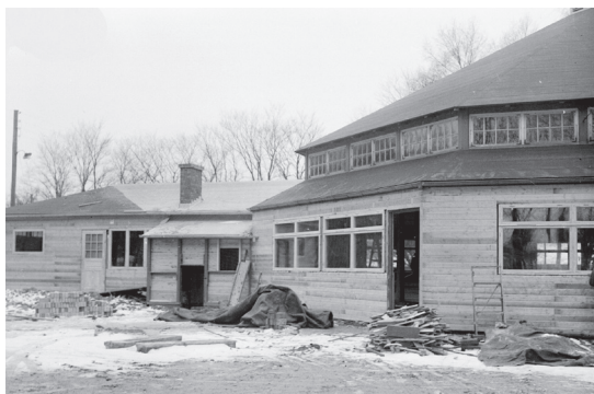
Dansrotundan Cecil under byggnad 1937. I början av 1940 kom byggnaden att användas som matsal för Flygreservskolan II som placerats på Eslövs flygfält. Foto via Eslövs Fotoklubb.
